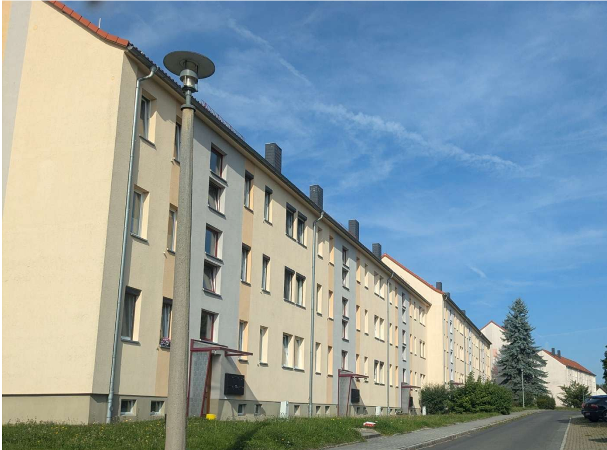
Abbildung 17 | Mehrfamilienhaus um 1960 mit erneuerter Dacheindeckung
