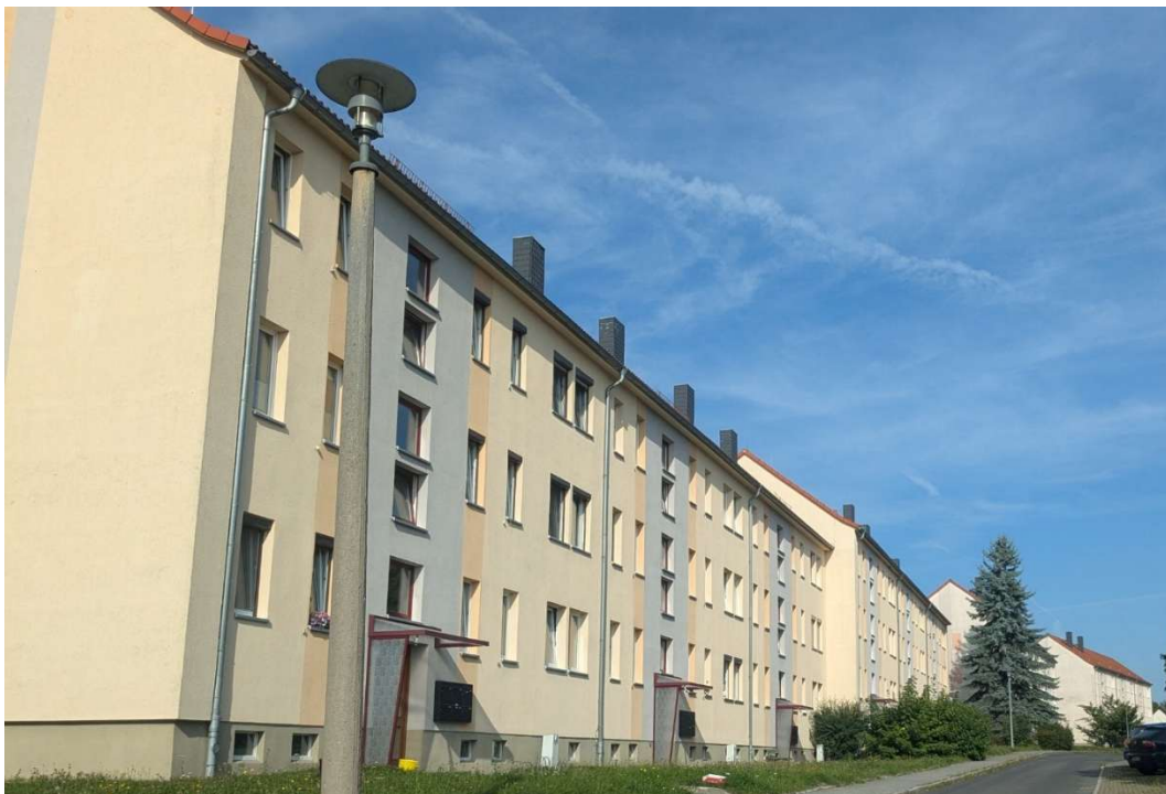
Abbildung 17 | Mehrfamilienhaus um 1960 mit erneuerter Dacheindeckung
