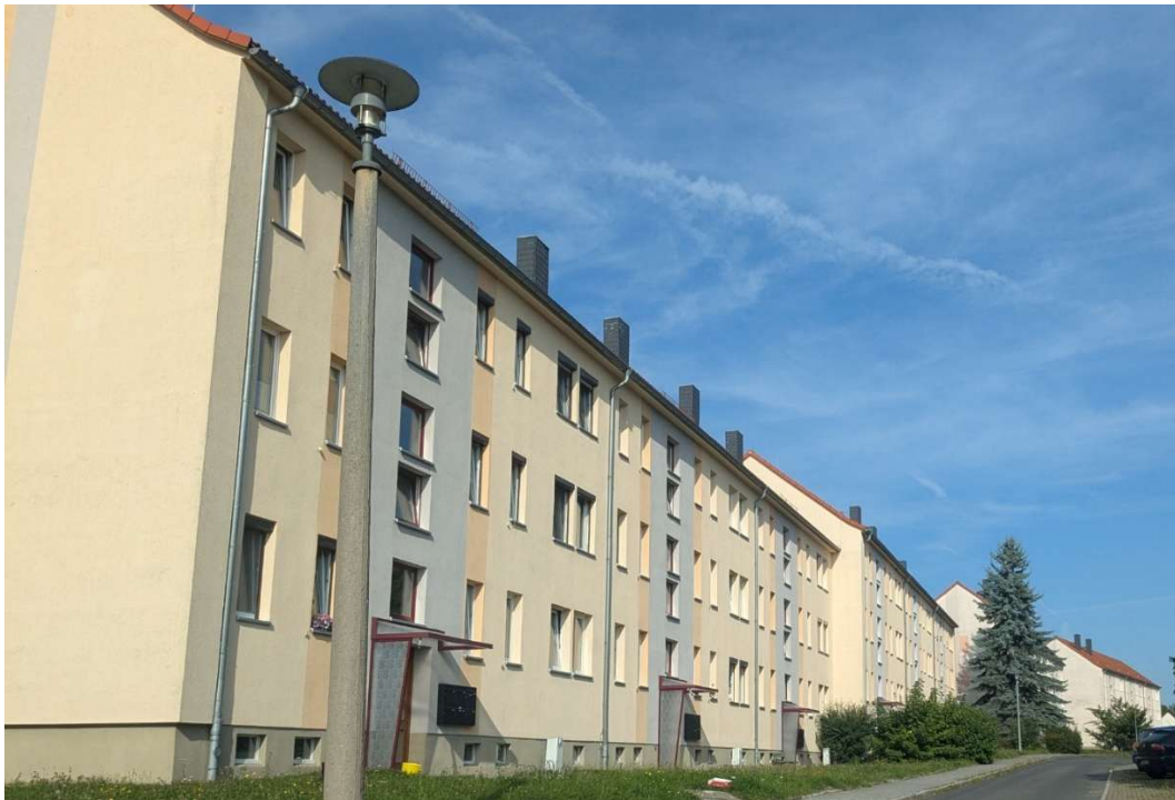
Abbildung 17 | Mehrfamilienhaus um 1960 mit erneuerter Dacheindeckung
